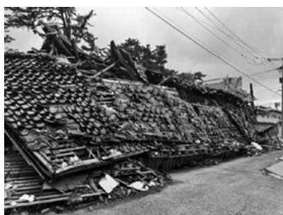
倒壊した家屋
